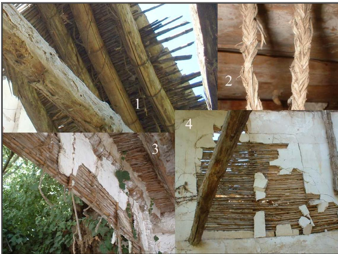
**Figura 10.** Plantas empleadas en construcción. 1. Vigas de chopo (*Populus sp.*) y cañas (*Arundo donax*) formando la techumbre y sujetando las tejas. 2. Cuerda trenzada de esparto (*Stipa tenacissima*) atando las vigas de una casa ruïnosa. 3 y 4. Restos de muros de cañizo y cal, con sogas de esparto.
